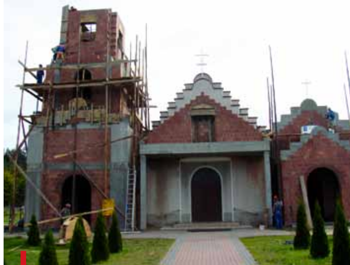
Rozbudowa kościoła pozwoli wszystkim parafianom pomieścić się w świątyni
