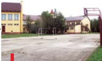
Boisko przy Zespole Szkół w Baranowie Sandomierskim już niebawem zostanie całkiem przebudowane
