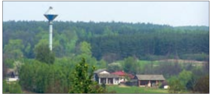
Wieżę ciśnieniową zbudowano na polu plebańskim, które parafia przekazała kopalni Osiek za symboliczną złotówkę. Czerpią z niej wodę: Osiek, Polaniec, Rytwiany i oczywiście Wiązownica
