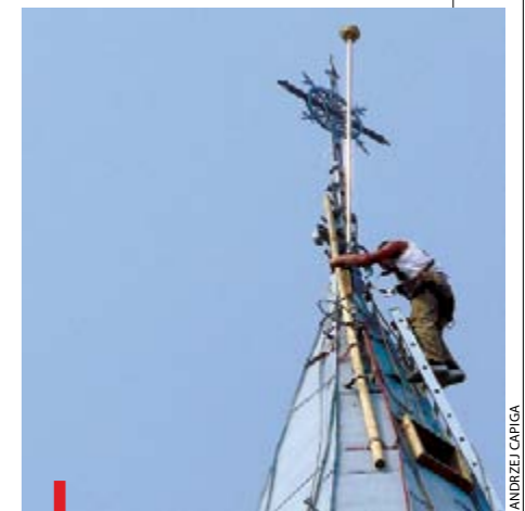
Montowanie kuli na kościelnej wieży
