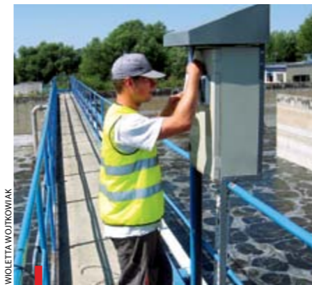
Komory biologiczne, najważniejsza część oczyszczalni
